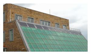
NÜRDAM 'da üretilen güneş panellerinin konulmasıyla çevre aydınlatma sisteminin enerjisi tamamen güneş enerjisinden sağlanmaktadır.
