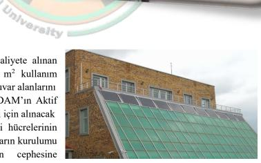
NÜRDAM 'da üretilen güneş panellerinin konulmasıyla çevre aydınlatma sisteminin enerjisi tamamen güneş enerjisinden sağlanmaktadır.
